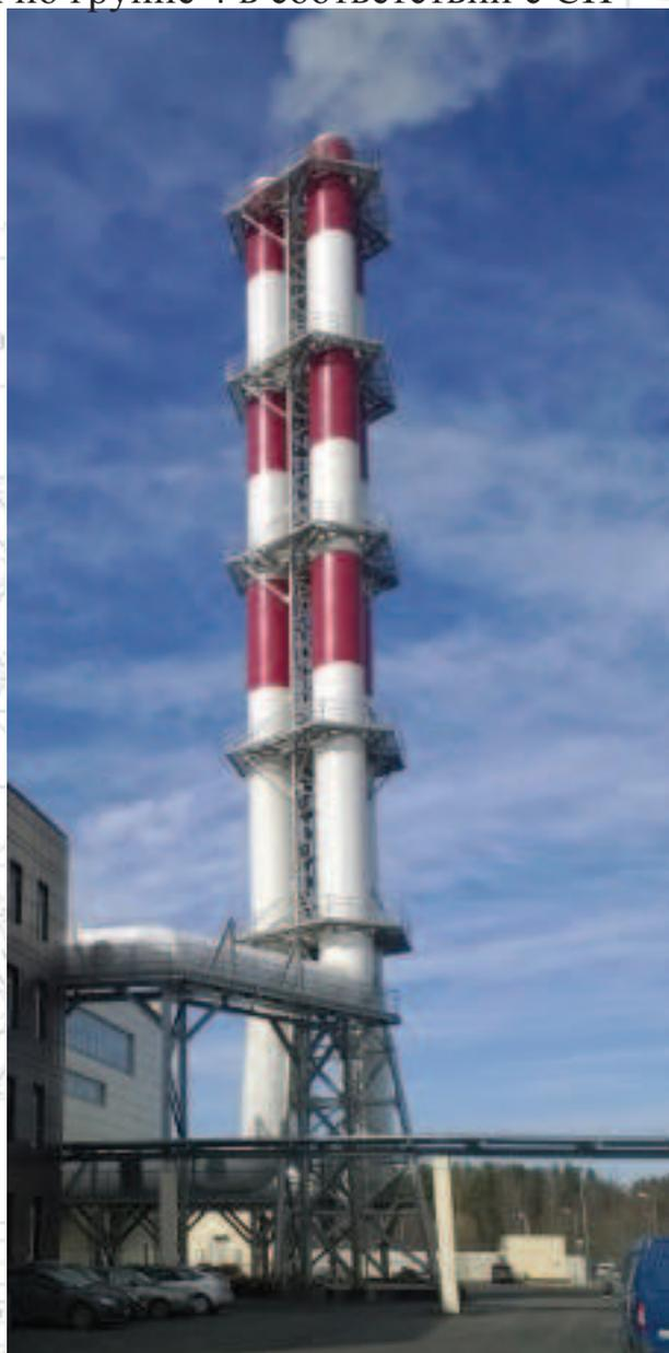
рис. 5. Газоотводящие стволы с вытяжными башнями.
