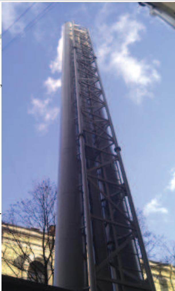
рис. 4. Вытяжная башня с 3 газоотводящими стволами.
