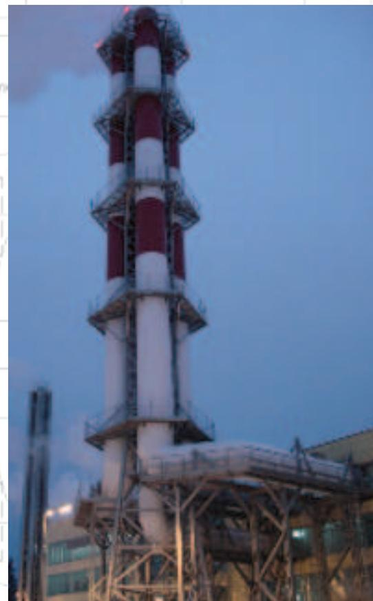
рис.9. Газоотводящие стволы Диаметры 3-х 2,300м. и одного 1,600м.
