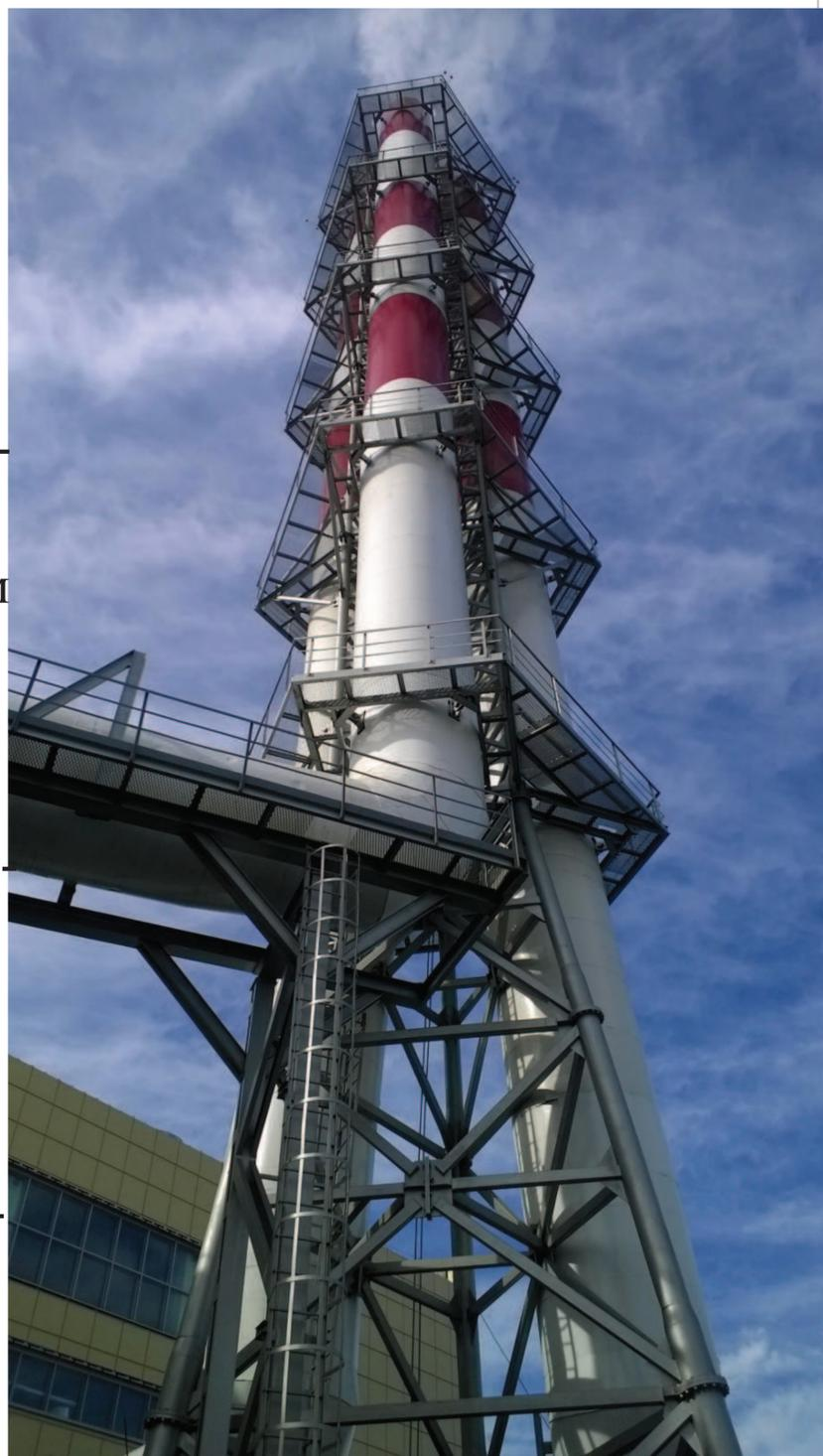
рис. 6. Вытяжная башня, высота 60 м. Внутренний диаметр 3-х стволов 2,300 м.
